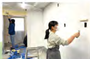
壁面の塗装はクラウドファンディングに参加いただいた方をはじめ、有志の皆さんと作業しました。
