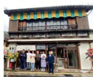
⑥岐阜まち家守 裏参道モールへの改装
