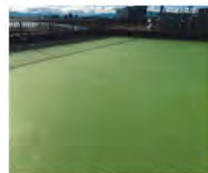
③長良川観光ホテル 石金 屋上スペースの改装
